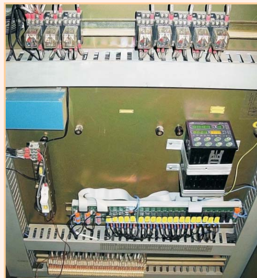
Рис. 8. Монтаж контроллера МИК-51 в щите управления АПО газа
