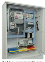
Рис. 4. Система дистанційного GSM-керування вуличним освітленням Смерті-ВУС.
